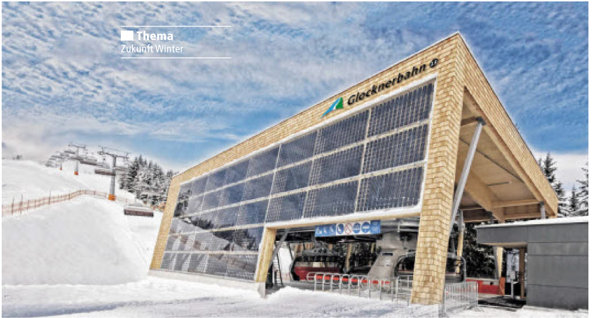
Skifahren verbraucht viel Energie, Lifte müssen betrieben und Pisten beschneit werden. In Salzburg gibt es Skiorte, die den Strom selbst erzeugen.
